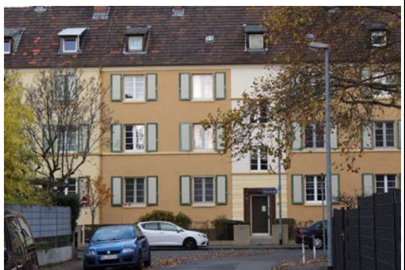
Ketteler-Siedlung (Blick auf die Görresstraße), 2019
